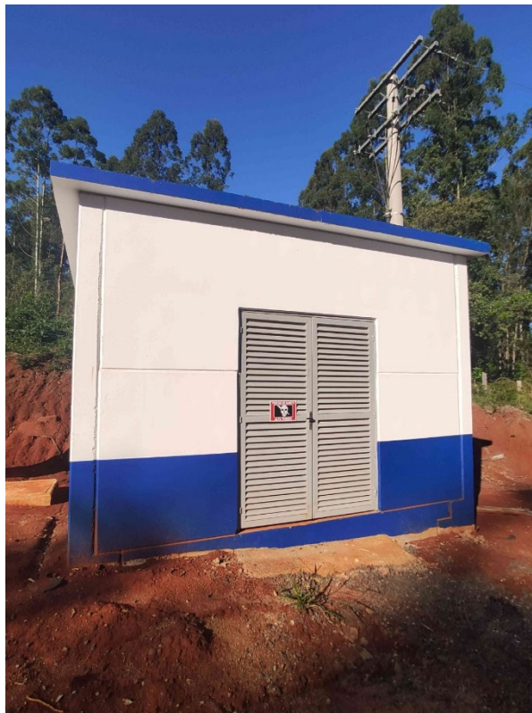
Cubículo de medição externa
